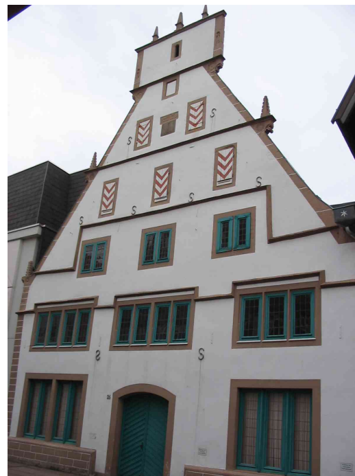
Abb. 4: Beim Bau des Kaufhauses Karstadt (heute Hertie) in Lemgo im Jahr 1973 wurde der gesamte Hauskörper des Hauses Mittelstraße 26 aus dem 14./15. Jahrhundert bis auf die spätgotische Fassade und eine barocke Stuckdecke, die im Neubau wieder angebracht wurde, abgerissen.
