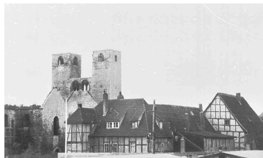
Abb. 41: Halberstadt. Paulsplan mit der Ruine der Paulskirche und Fachwerkhäusern. Alle Gebäude auf dem Foto wurden 1969 abgerissen, um Platz für eine Schule und Wohnhäuser zu machen.
