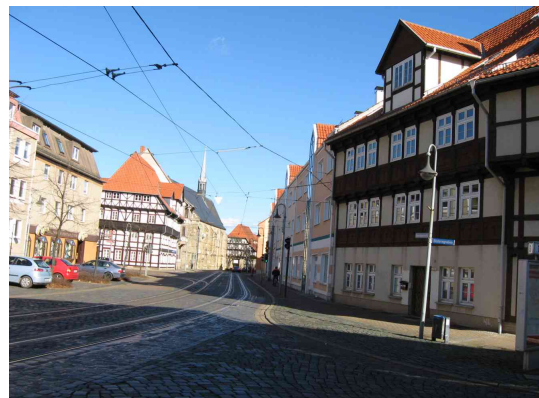
Abb. 47: Halberstadt, Dominikanerstraße. Zu Beginn der Flächensanierungen bemühte man sich noch um eine Einpassung der Neubauten (rechte Straßenseite).
