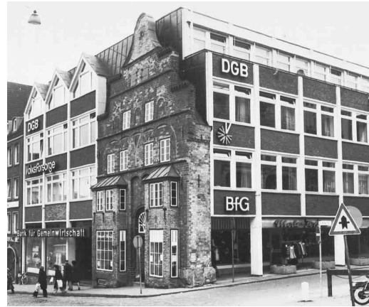
Abb. 3: Das Renaissancehaus Südermarkt 11 in Flensburg wurde 1971 bis auf die Fassade für einen Neubau abgerissen.
