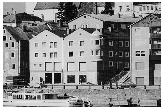
Abb. 34: Passau-Ilzstadt. Neubau Löwenmühlstraße 13 mit Erker in Anlehnung an den Vorgängerbau.
