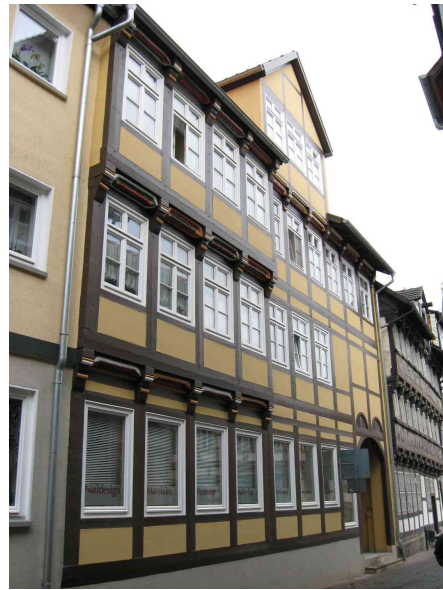
Abb. 58: Osterwieck, Der Neubau von Mittelstraße 24-25 nimmt die Grundform der beiden Vorgängerbauten wieder auf, verwendet jedoch bis auf einige Knaggen und Füllhölzer keine alten Bauteile.
