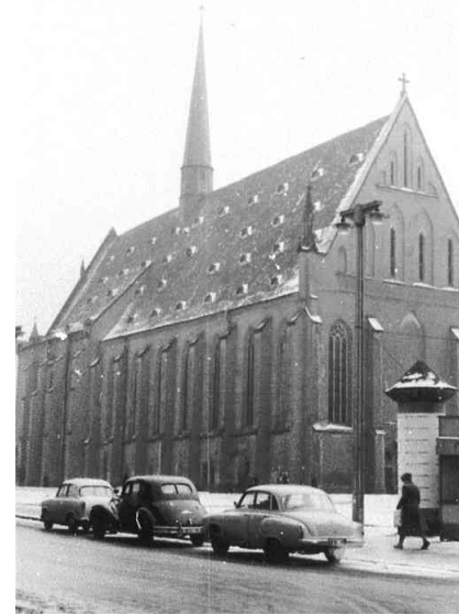
Abb. 39: Die Universitätskirche in Leipzig im Jahre 1961, sieben Jahre vor dem Abbruch.
