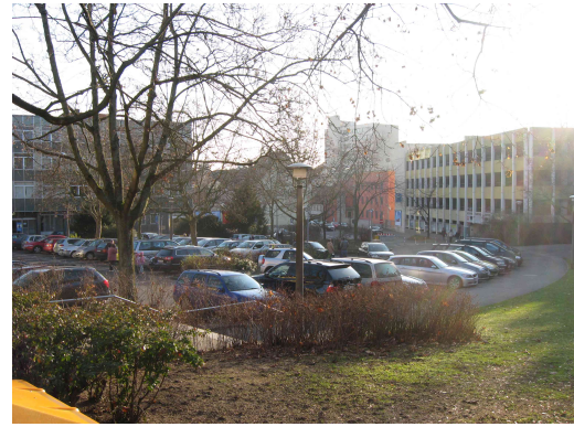
Abb. 18: Schweinfurt. Der bis heute nicht wieder bebaute Nordteil der Hadergasse bildet eine städtebauliche Lücke. Rechts im Hintergrund das 1978 erbaute Parkhaus.
