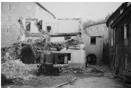
Abb. 33: Passau-Ilzstadt. Abbruch des Hauses Löwenmühlstraße 13.
