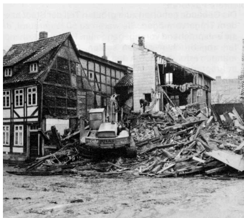
Abb. 70: Hameln. Gebäudeabbrüche in der Bungelosenstraße.
