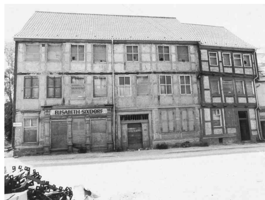
Abb. 44: Halberstadt. Leer stehende Häuser in der Bakenstraße. 1992.
