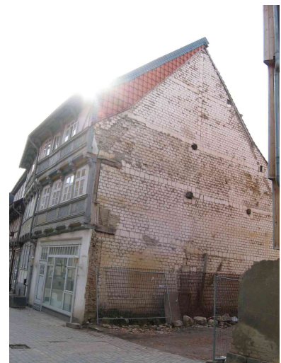
Abb. 64: Osterwieck. Das aus dem 16. Jahrhundert stammende Haus Mittelstraße 18 wurde erst vor wenigen Jahren abgerissen.
